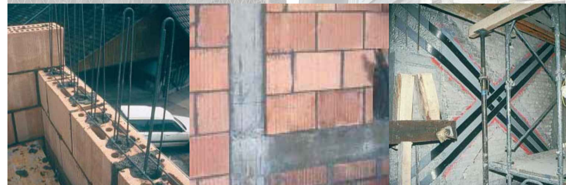
LJEVO: ARMIRANJE OPEKE, SREDINA: BETONSKI SERKLAŽ, DESNO: ARMIRANJE ZIDA UGLJIČNIM VLAKNIMA (IZVOR: SEIZMIC CONCEPTUAL DESIGN OF BUILDINGS, HUGO BACHMANN)
